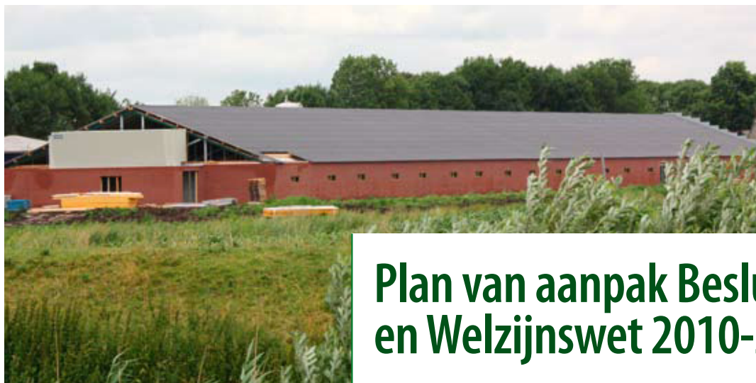
Stal met luchtwasser in aanbouw
